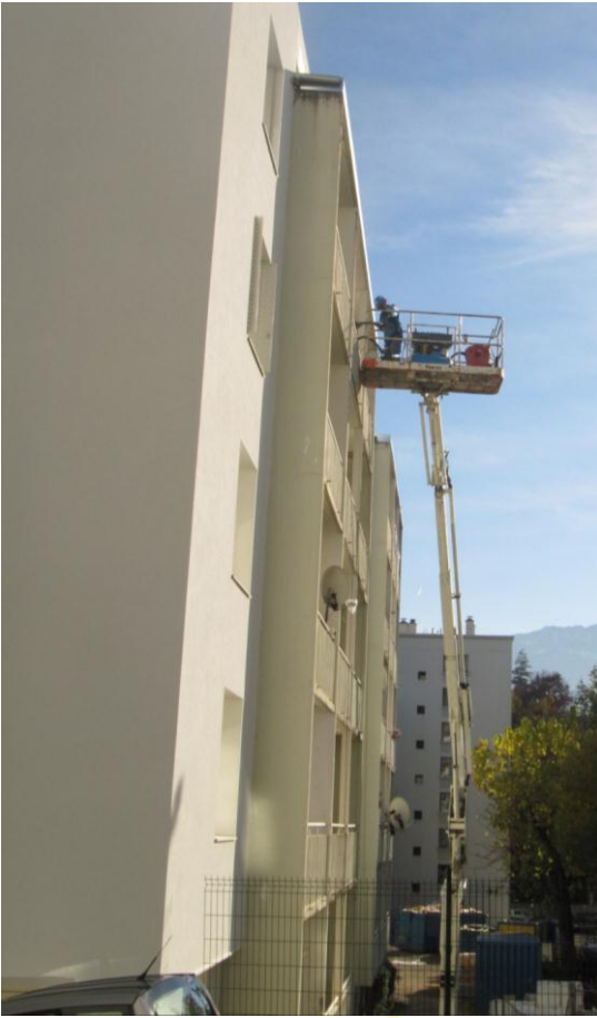
Renforcement des balcons par injection de résine
